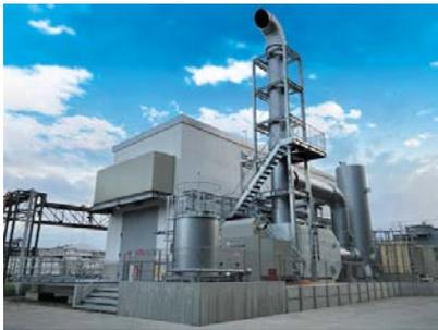
設置したガスコージェネレーションシステム外観
