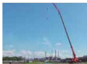
大型クレーンを使った投下試験を実施
