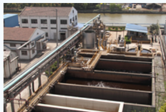
無錫先進化薬化工（有）の廃水処理設備
