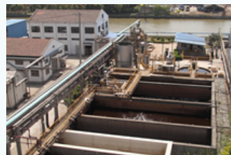
無錫先進化学化工（有）の廃水処理設備
