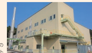
厚狹工場の 触媒製造用プラント
