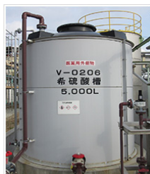
作業者がばく露するおそれのある化学物質の危険有害性を認識できるようしています
