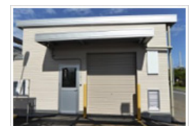
パイロット実験施設
