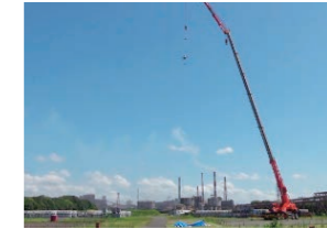
大型クレーンを使った投下試験を実施
