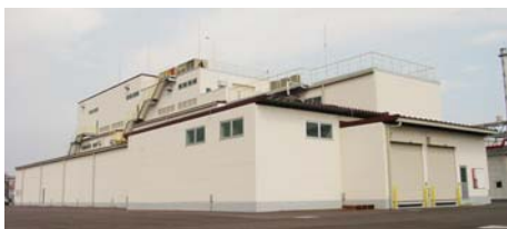
新設した光学機能性フィルム生産工場
