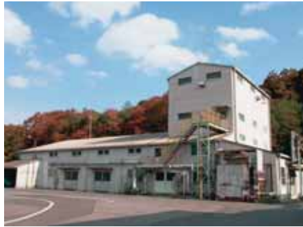
含水爆薬製造工室
