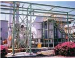
排ガス処理装置(1996)
